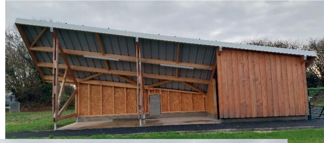
Ombrières photovoltaïques Maison de l'enfance de Saint-Jean d'Elle
