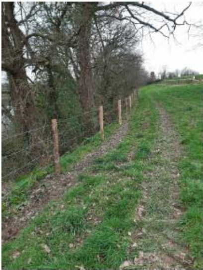
Installation d'une clôture en périmètre immédiat du barrage de Fumichon (Source : Mailys Lesage)
