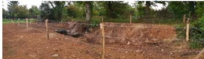
Après travaux – mare à Moon-Sur-Elle (source : Maïlys Lesage)
