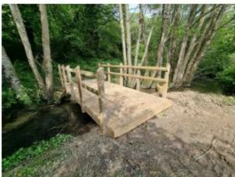
Passerelle sur cours d'eau (source : Alexis Bon)
