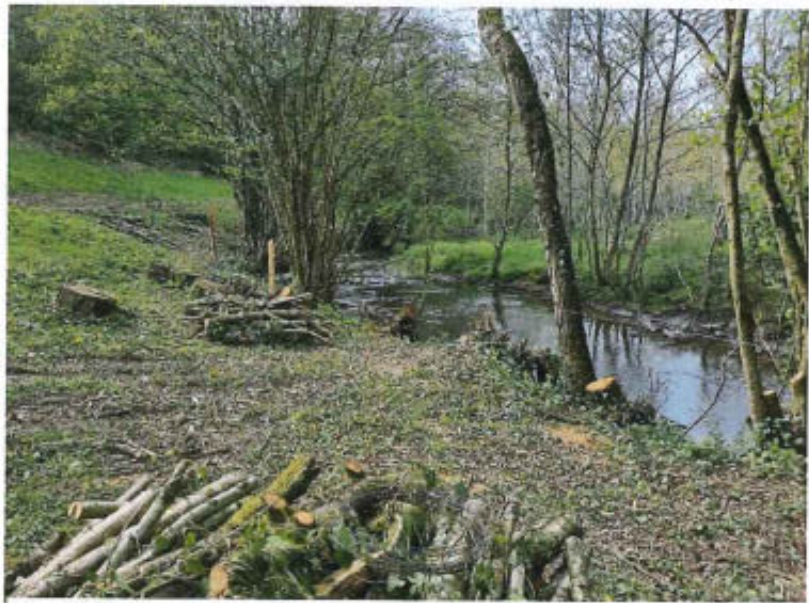
FIGURE 17 ENTRETIEN DE LA VEGETATION ET POSE D'UNE CLOTURE D'UN FIL ELECTRIQUE EN BORD DE JACRE
