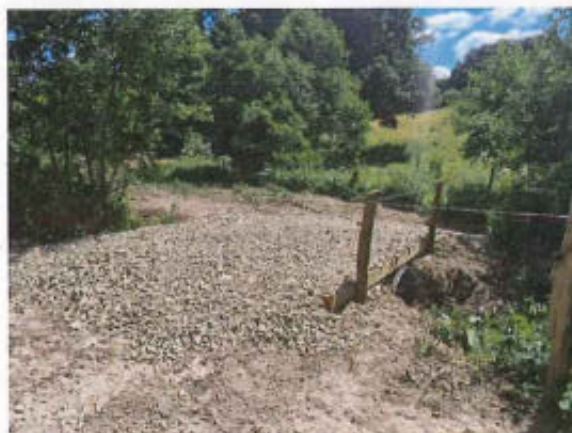
FIGURE 16 PASSAGE DEMI-HYDROTUBE PERMETTANT LE PASSAGE D'ENGIN LEGER ET DES BOVINS SUR UN AFFLUENT DE LA JACRE
