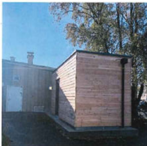
FIGURE 30 MISE EN PLACE DU MODULE DE CHAUFFERIE
