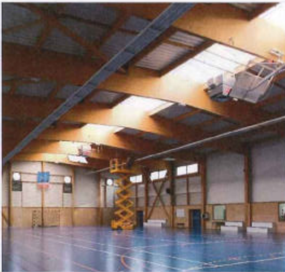
FIGURE 27 MISE EN PLACE DES SOUFFLEURS GYMNASSE DE TASSY BOCAGE
