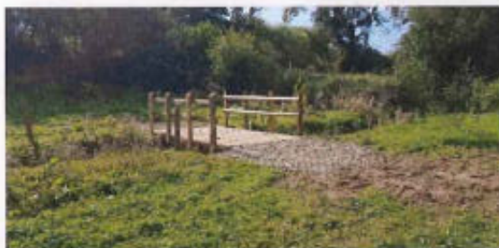
FIGURE 13 PASSERELLE EN BOIS POUR BOVINS ET PETITS ENGINS SUR L'HAIN
