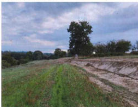
FIGURE 25 CREATION DE TALUS PREALABLE A UNE PLANTATION, LA MONTERIE A SAINT-LO
