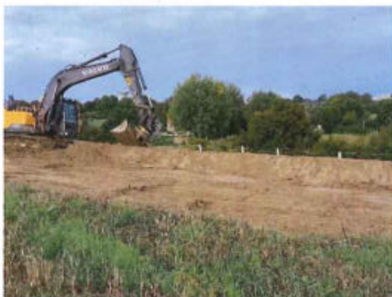
FIGURE 24 CREATION DE TALUS PREALABLE A UNE PLANTATION, LA MONTERIE A SAINT-LO
